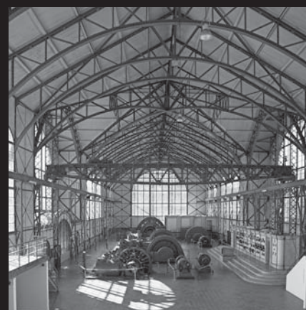
Blick in die Maschinenhalle
